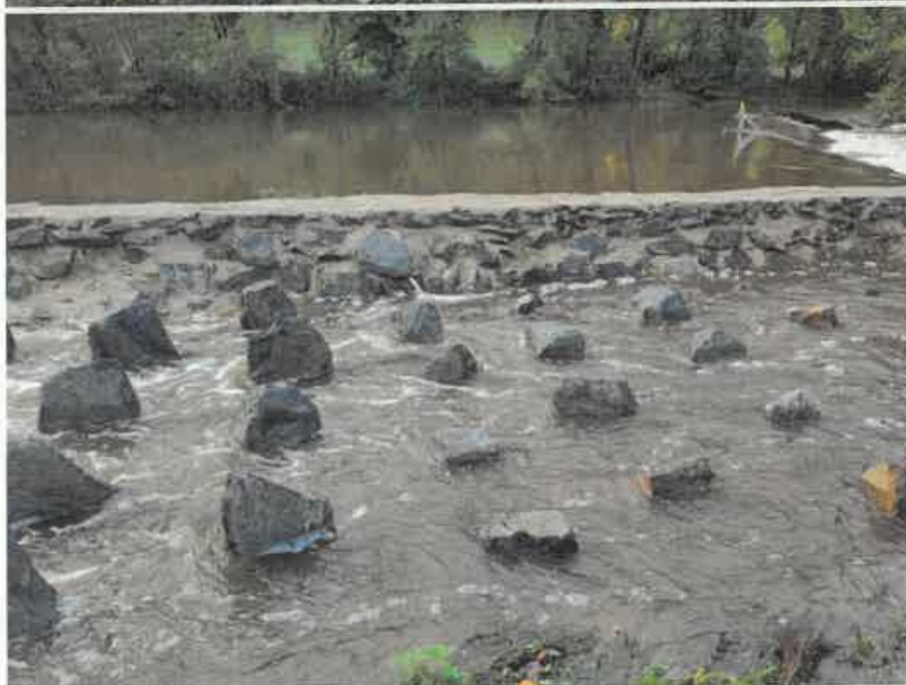
Vues de la rampe ce jour
